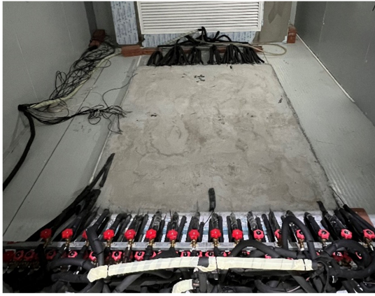
(b) 毛细管地板辐射供暖末端
